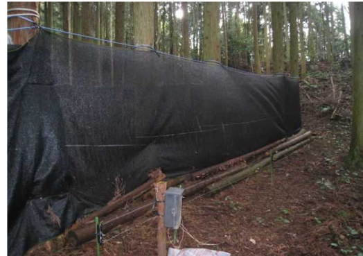
事例2: 安岐町O氏 (下に丸太、上にロープ)
