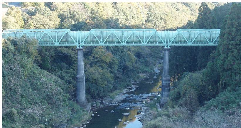
(大野川発電所 三重川水管橋)
