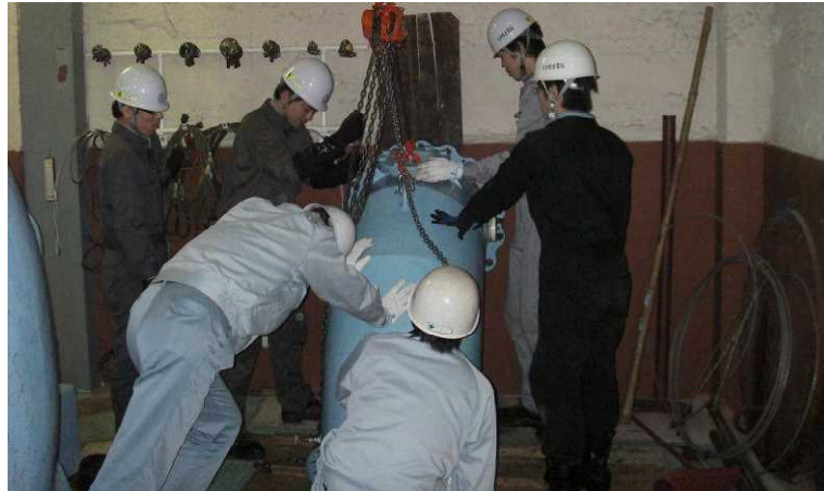
(芹川第三発電所 定期停止作業)
