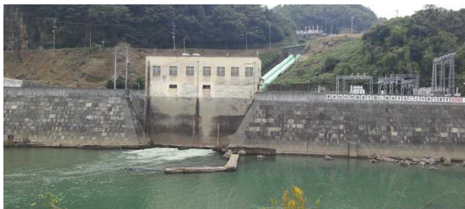
（大野川発電所 全景）
