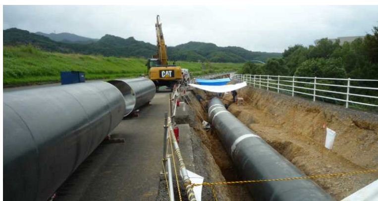
(松岡・大津留線 鋼管布設工事)
