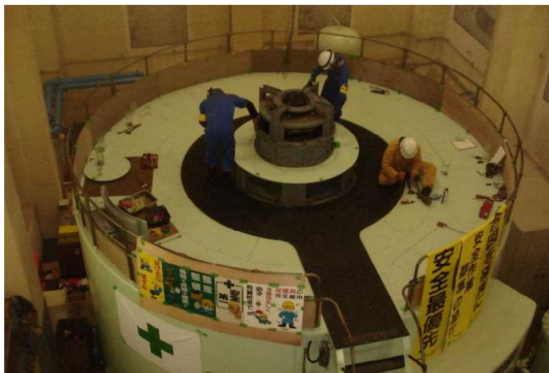
(参考：芹川第一発電所 オーバーホール工事)
