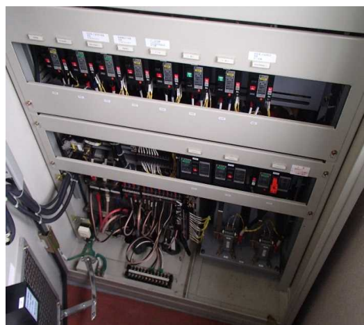
(判田取水場 無停電電源装置)
