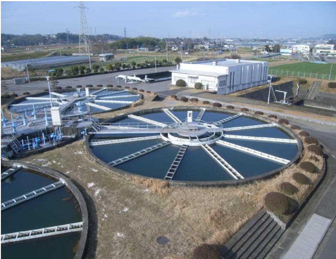
(大津留浄水場)
