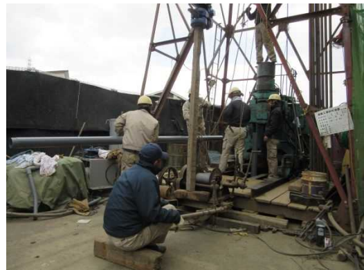
温泉掘削工事の状況
