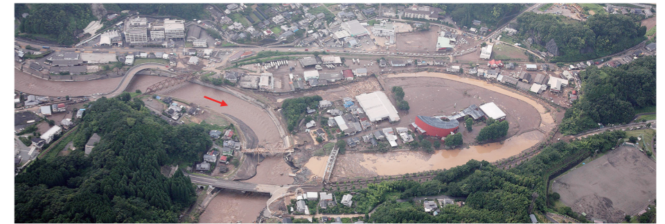
平成24年7月出水の状況 (玉来川 竹田市文化会館付近)
