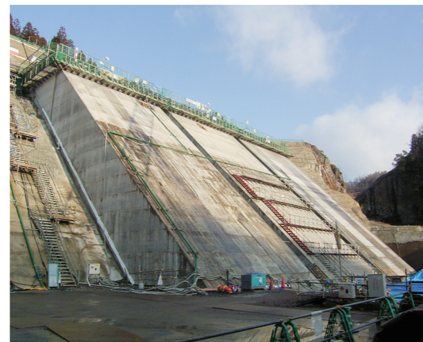
稲葉ダムの左岸造成アバットメント
