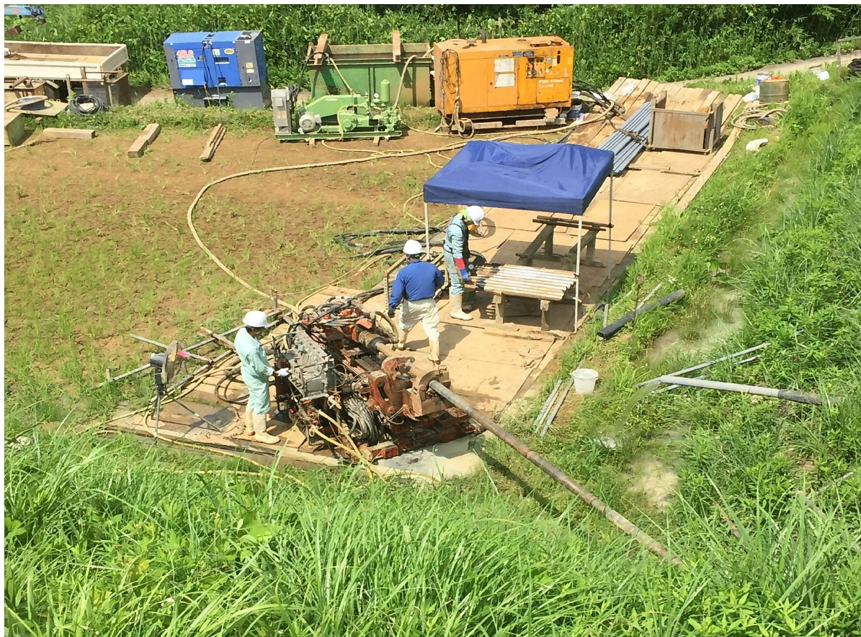
Y-4排水ボーリング工作業状況
