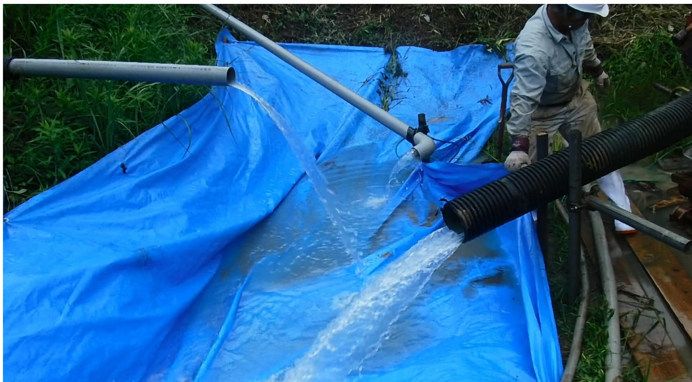
Y-4排水ボーリング工排水状況
