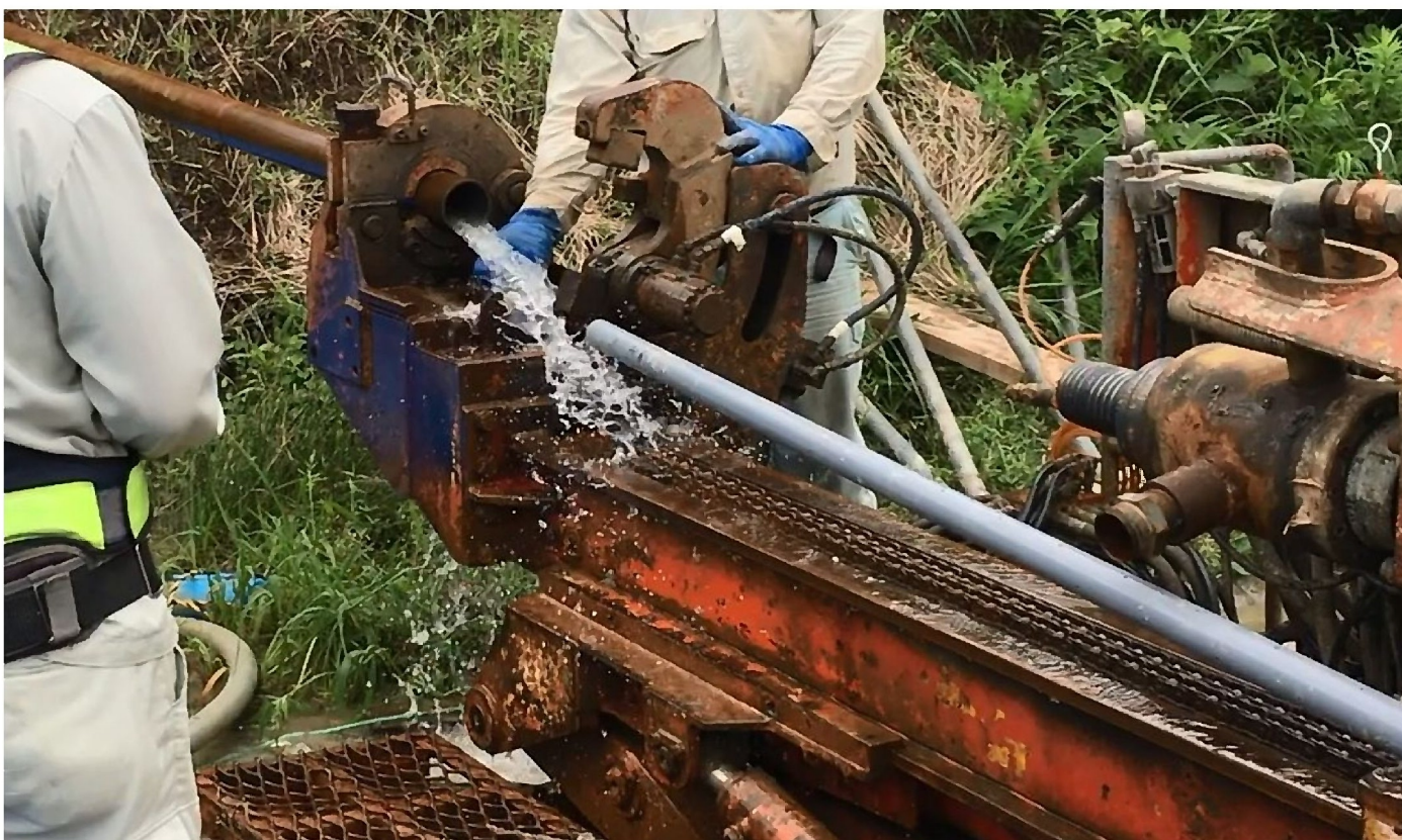
Y-4排水状況
