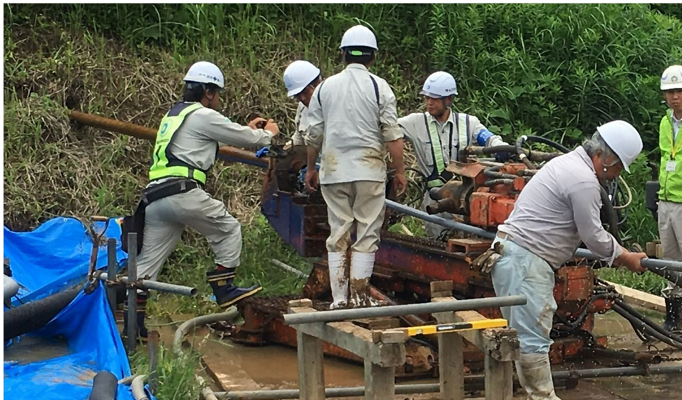
Y-4排水ボーリング作業状況
