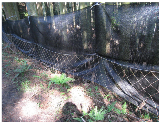
(被害対策 武蔵町)
