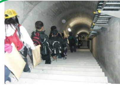
■ ダム堤体内の監査廊。急な階段が続く。この先にダムのバルブ室などがあります。
