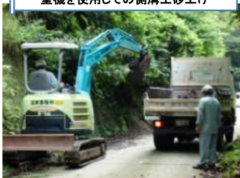
重機を使用した側溝土砂上げ
