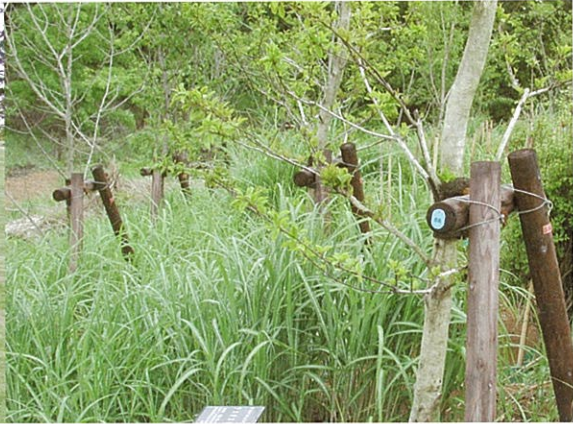
写真17 支柱工 (H12, 湯布院町)
