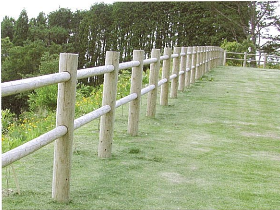
写真16 進入防止柵工 (H12, 大野町)
