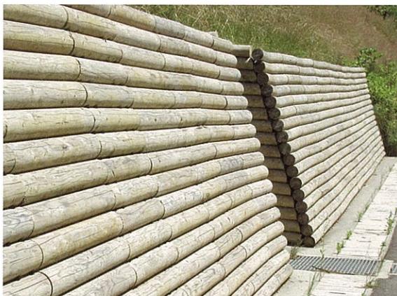
写真20 化粧型枠工 (H11, 大野町)
