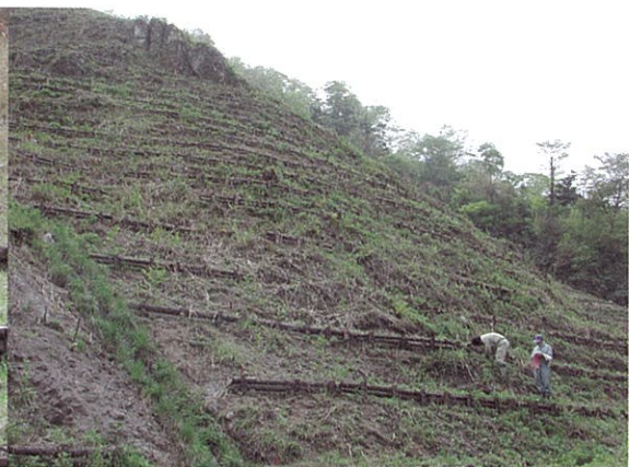
写真5 筋工 (H 10, 宇佐市)
