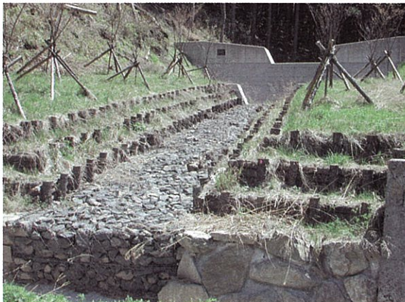
写真6 流路工 (H 10, 竹田市)
