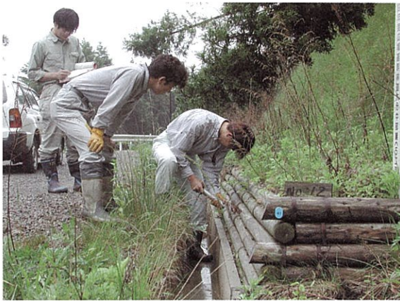
写真10 L型丸太積工 (H 9, 庄内町)
