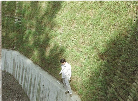
写真19 補強土壁面工 (H11, 野津町)
