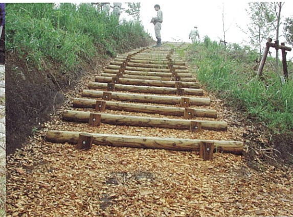
写真15 階段工 (H 12, 湯布院町)
