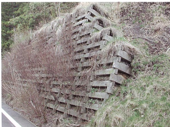
写真8 井桁積土留工 (H 7, 日田市)
