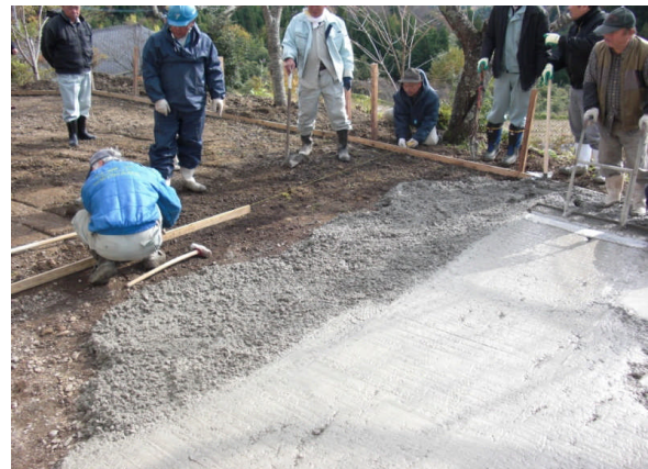
市が調達したコンクリートを打設
