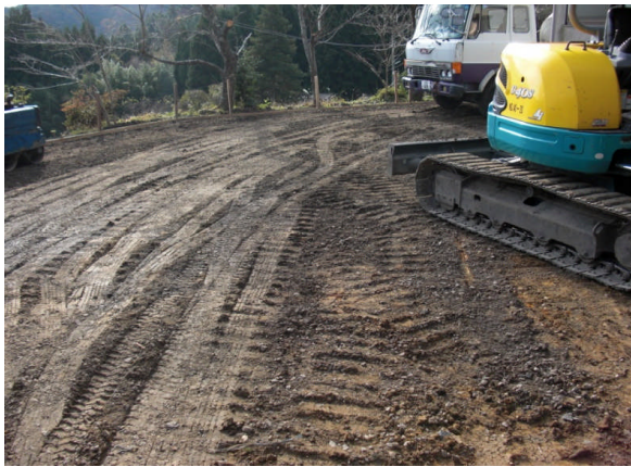
舗装前の整地作業
