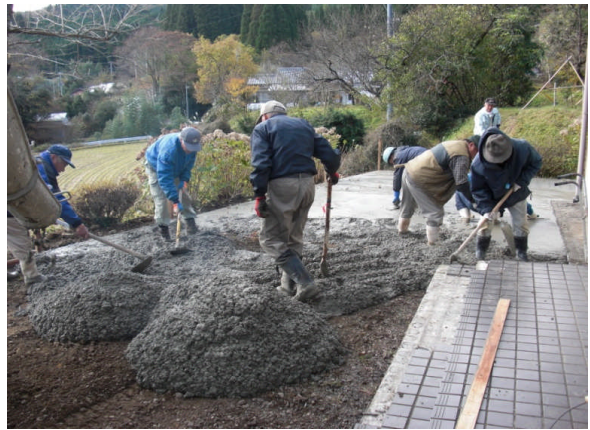
市が調達したコンクリートを打設
