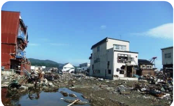
大津波により被災した町の様子 (2011. 6. 11撮影)
