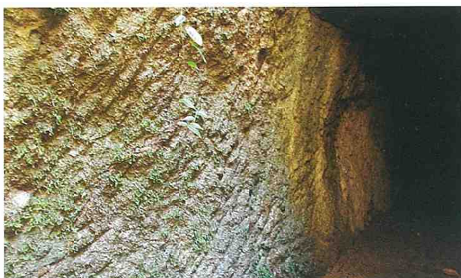
5 藤ヶ谷の隧道の内部 トンネル内部には鑿の跡が残っています
