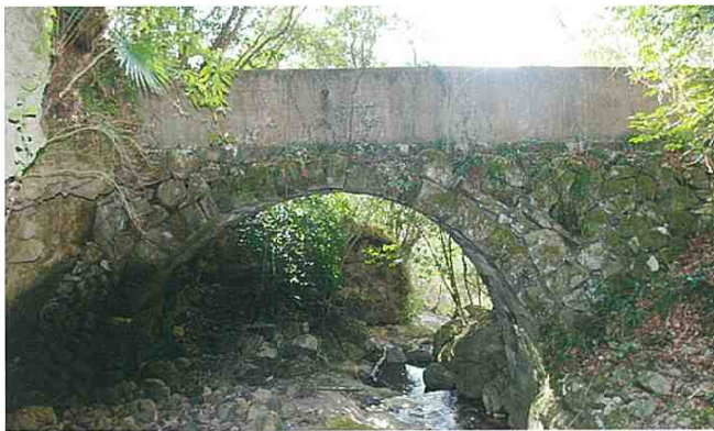
3 藤ヶ谷水路橋 石工・児島組の技術が活かされています
