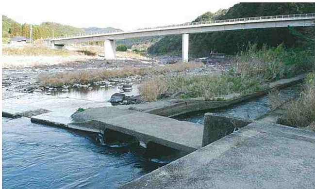
1 取水口 津房川東岸につくられた取水口です (宇佐市院内町広瀬)
