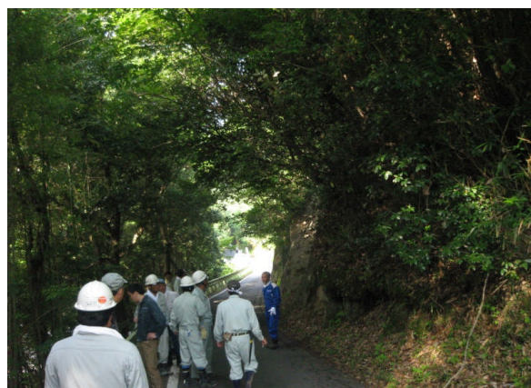
木伐採作業前
