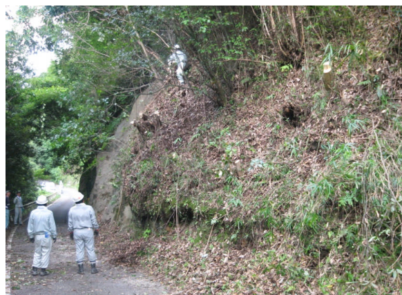
木伐採作業後
