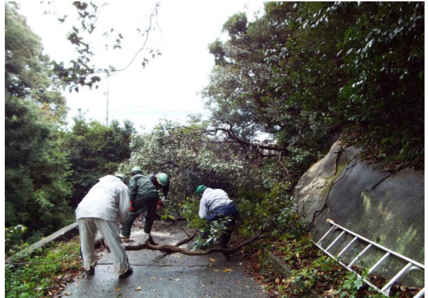
農道に生い茂る樹木を伐採中
