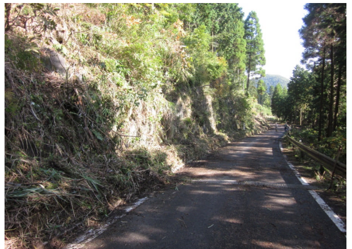
作業後の集落道
