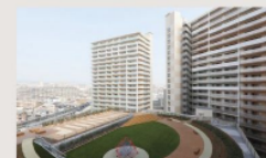
屋上庭園「空の里庭」
