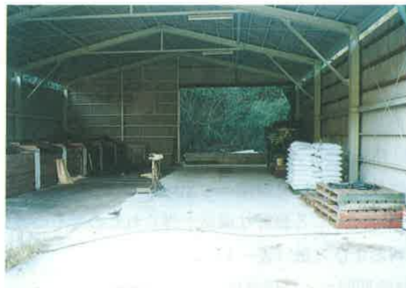
写真-5 堆肥倉庫
