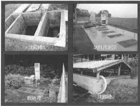
図1 処理施設の外観
