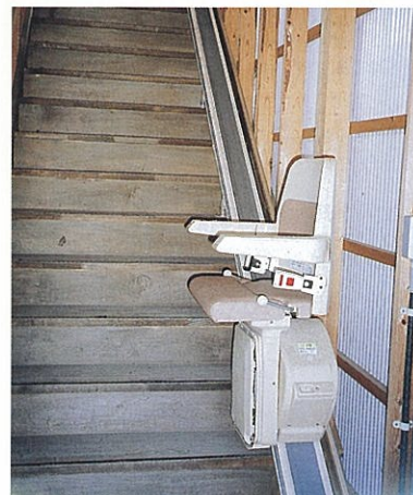
階段に昇降機を取り付けているため、 からだの不自由な人でも上り下り が可能です
