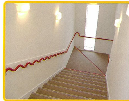
手すり 昇るときには力を入れやすく、 降りるときにはすべりにくい。
