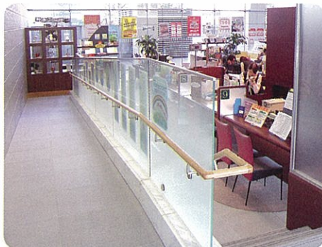
幅が広く、勾配がゆるやかなスロープ
