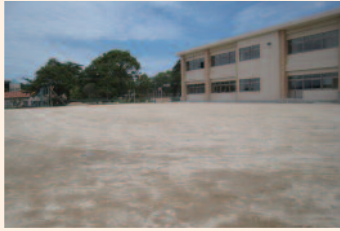
(1) 施工前のグラウンドです。
