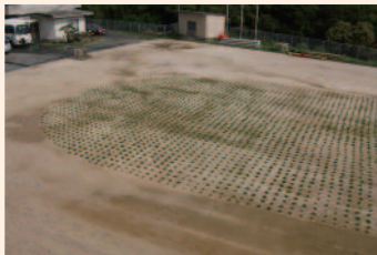
(1) 施工後はたっぷり散水します。
