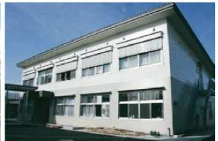
新築の定時制棟
