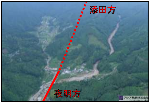
筑前岩屋駅構内 55k070付近
