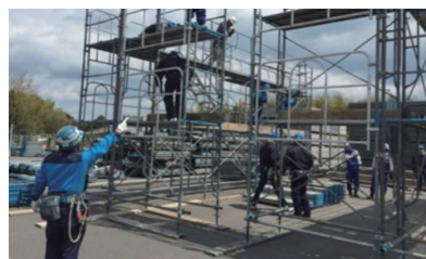
実習（外部足場組立演習）
