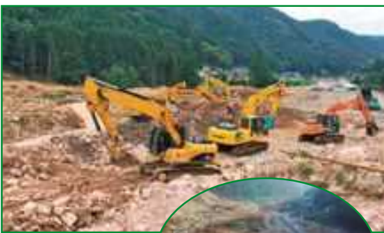
〈復旧工事後〉橋脚を無くし、川幅を広げ、川底の掘り下げを行っている。
