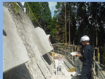
災害防除工事(保全班)の現場研修
