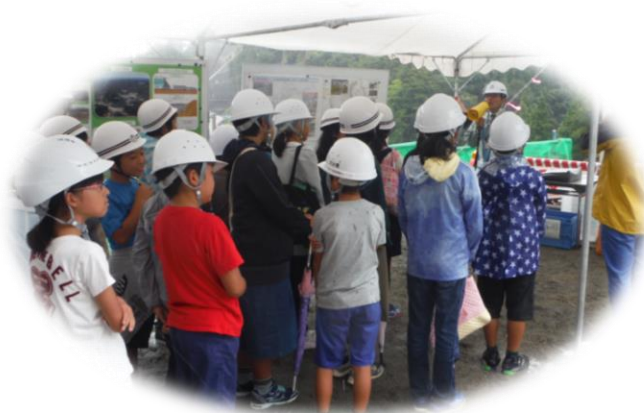
玉来ダム建設現場にて説明
