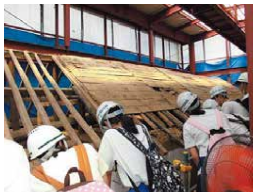
文化財の修復現場公開（草野家住宅）
