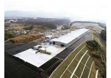
原木の地産地消の拡大につながる合板工場
