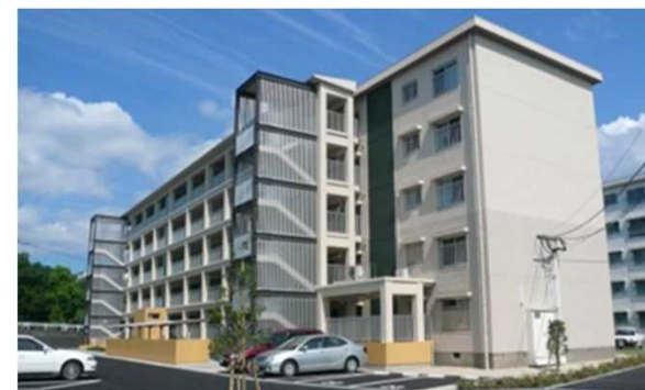
バリアフリー化改修：共用廊下とエレベーターの設置
