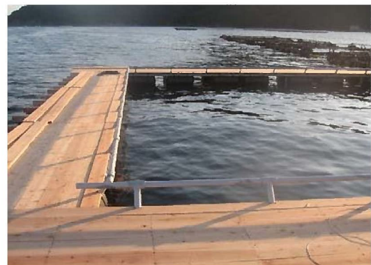
建設中の生け簀
