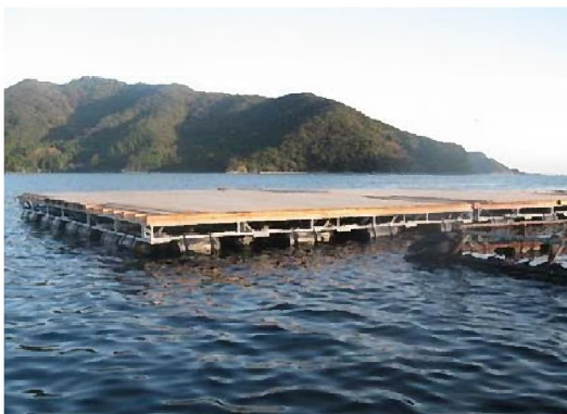
建設中の筏（ここに屋形が設置されます）
