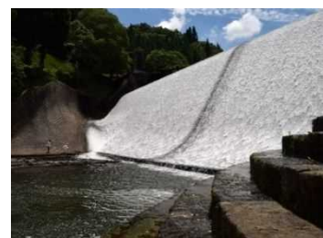
白水溜池堰堤水利施設
