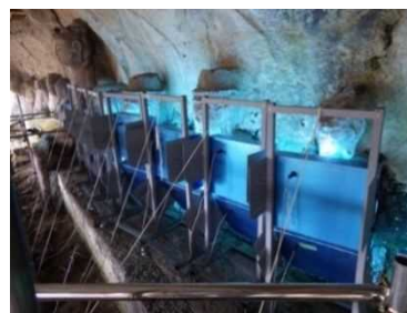
紫外線照射装置を用いた着生生物類の除去
