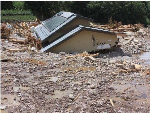
斜面崩壊の土砂が谷を越えて家屋を埋めた
