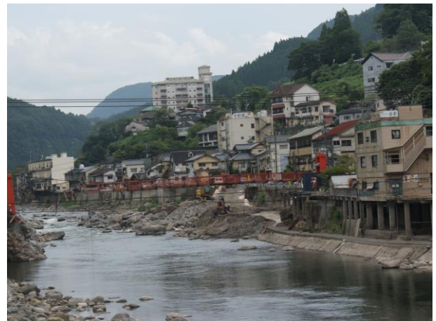
被災した吊り橋と温泉街
