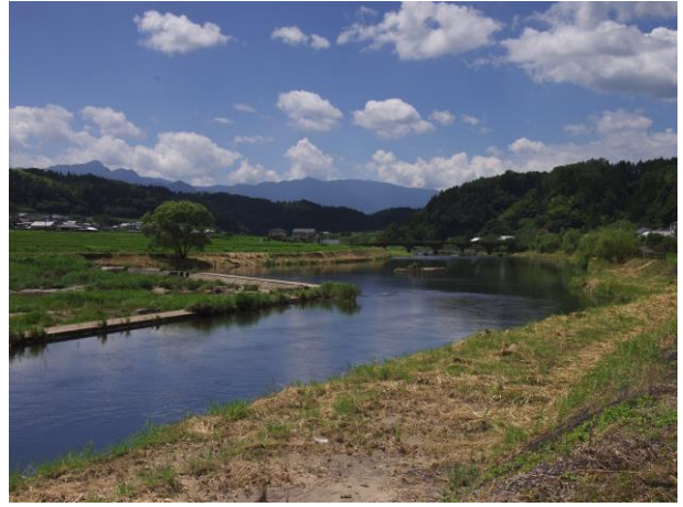
緒方下井路 取水堰
