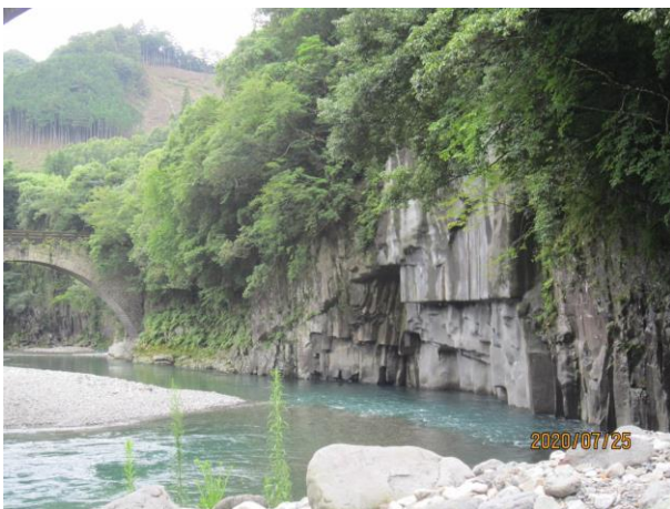
熊本地震による崩落後修復された轟橋下右岸の岸壁
