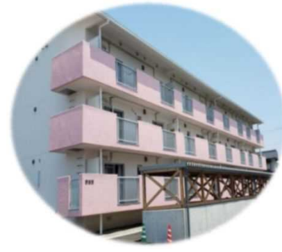
国東高校 寄宿舎(改修後の様子)
