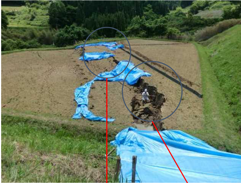
水田に生じた 陥没帯と段差亀裂
