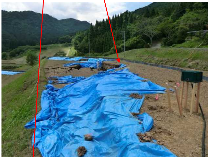
水田に発生した段差亀裂 段差約1.5m
