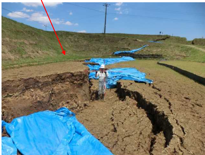
頭部の開口亀裂 幅約2m、段差約1.5m
