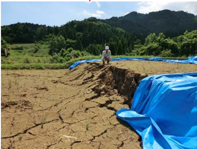
水田に生じた段差亀裂 段差約1m
