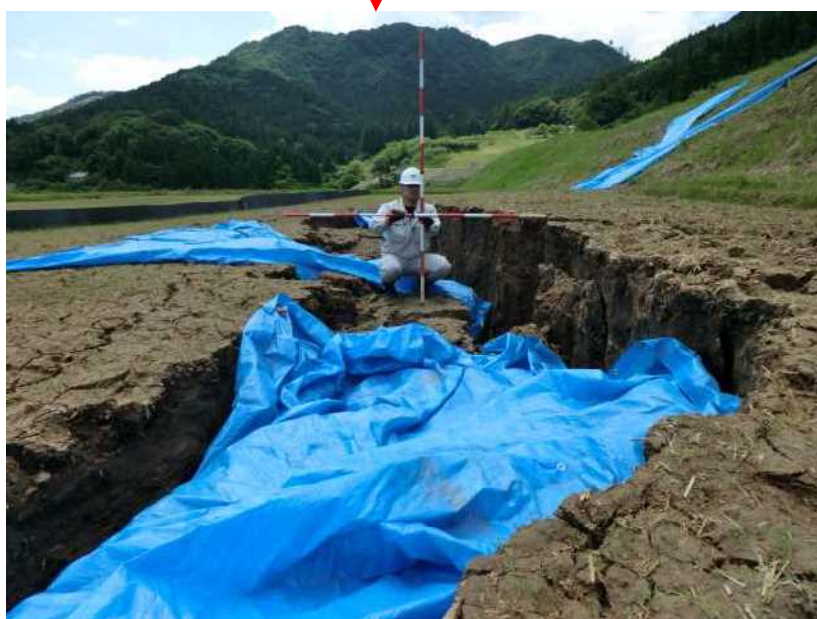
頭部の開口亀裂 幅約2m、段差約70cm
