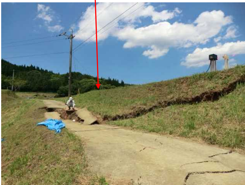
市道の開口亀裂 幅約1m、段差約70cm
