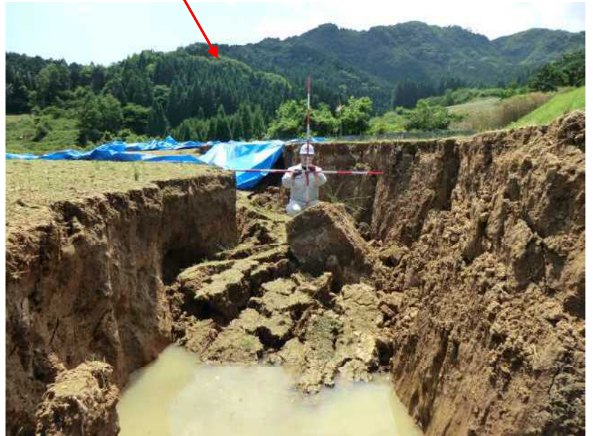
水田に生じた開口亀裂 幅約2m、段差約1m
