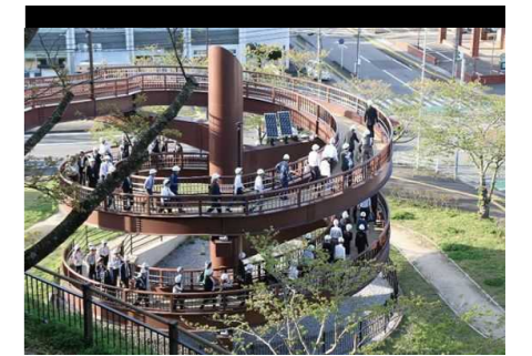
津波の災害時避難用の白杵公園ループ橋
