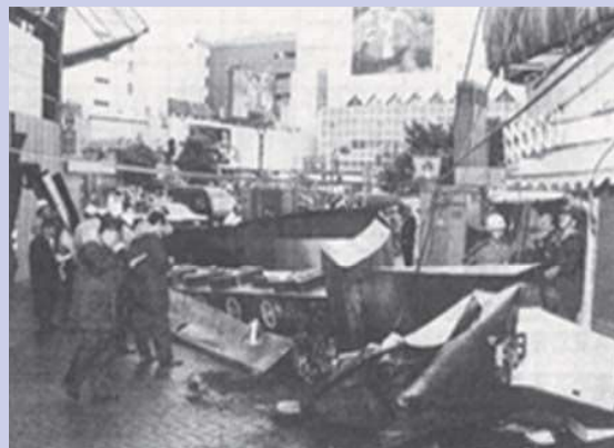
台風で落下した時の様子
