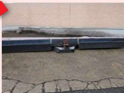
落下した欄間看板
