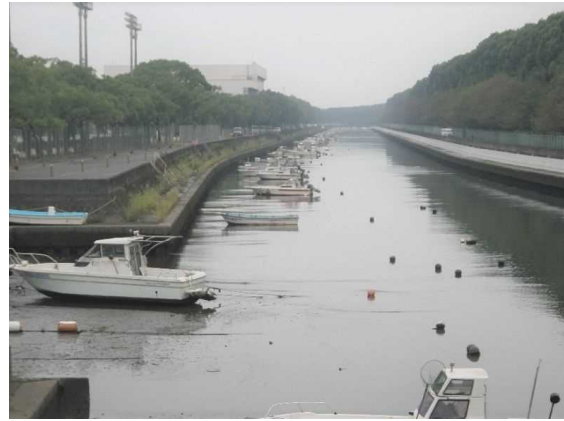
写真-2 裏川係留状況（2019年）
