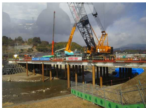
花月川橋梁復旧工事の現状
