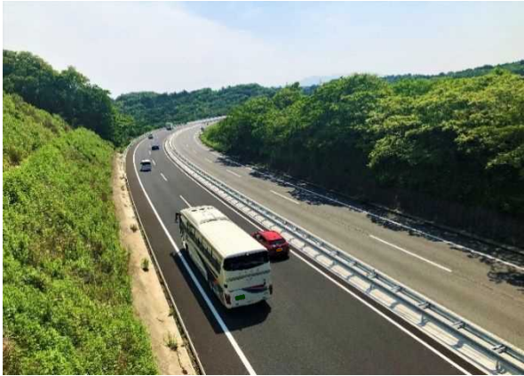
▲ 国道213号(一)糸原杵築線 (大分空港道路) 杵築市相原～大内
