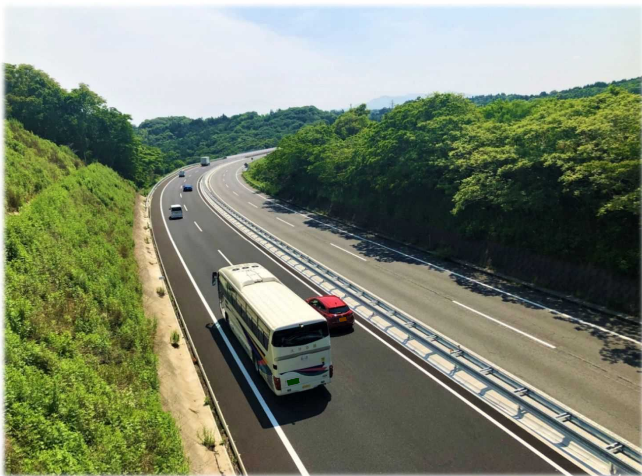
国道213号・一般県道系原杵築線（大分空港道路）
