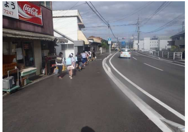
▲ 日田玖珠線 (上城内工区 歩道設置) 日田市上城内
