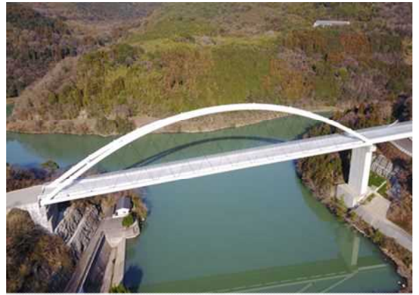
▲ 大田杵築線 (溝井工区) 杵築市大字石山～大字溝井
