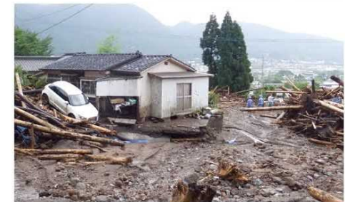
平成24年7月1日の梅雨前線豪雨の被害状況/岳本川(由布市)
