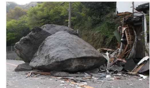
平成28年4月の熊本地震による被害状況/深耶馬地区(中津市)
