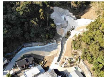
災害関連緊急砂防事業 楠屋川1（津久見市）
