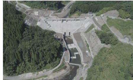
玉来ダムの竣工(R4.11)
