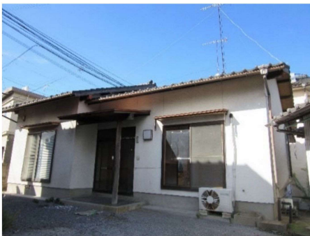
写真-1 外観（南面）
