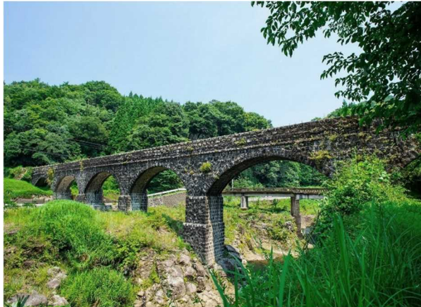
明正井路第一拱石橋
