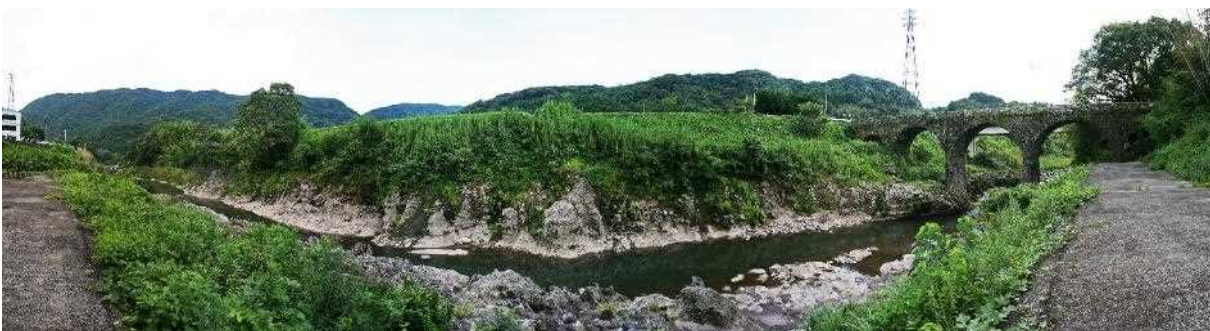
院内の谷地形と鳥居橋
