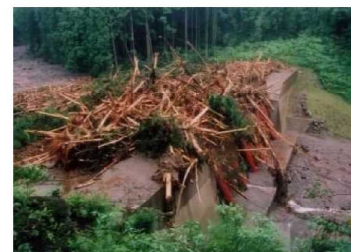
流木捕捉式治山ダム
